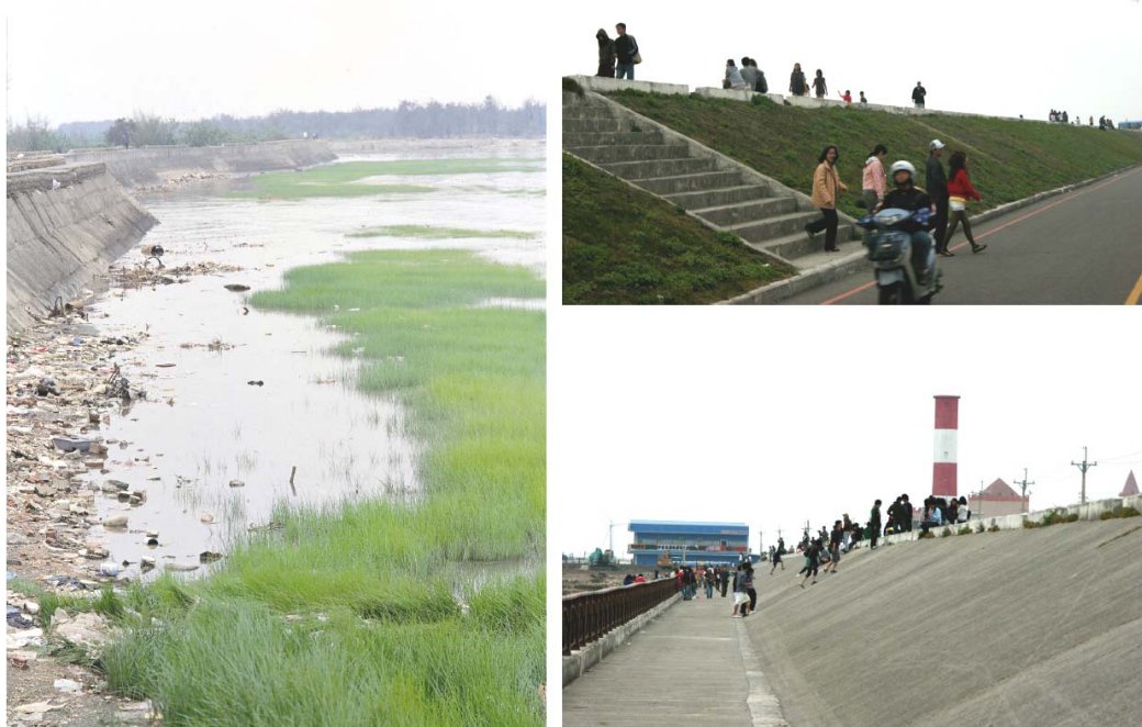
圖 4-10 堤防斷面的前後差異：（左圖）舊高美二號堤防外側，可看出約 45 度的斜坡；（右圖）現況以「親水」為考量的二號堤防內（上）與外（下）。
