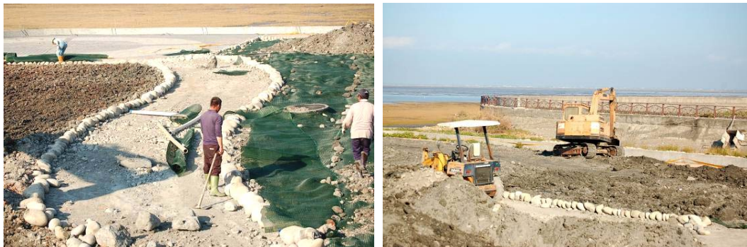
圖 4-13 2008 年 11 月刻正施工中的高美灘地「解說半島」雖以「生態工法」施作，但居民卻無法藉由施工過程理解生態工法的生態意義。資料來源：郭奇正拍攝
