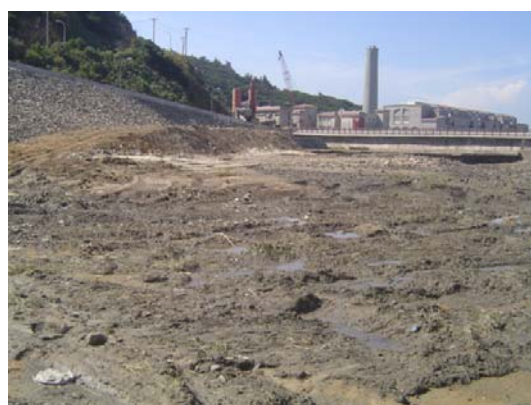
魚池周邊施工完成
