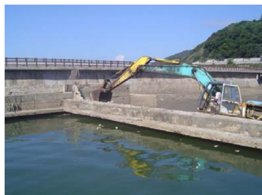
魚池及周邊施工
