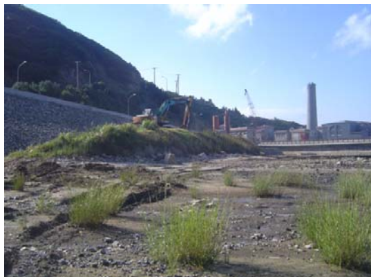
魚池及周邊施工
