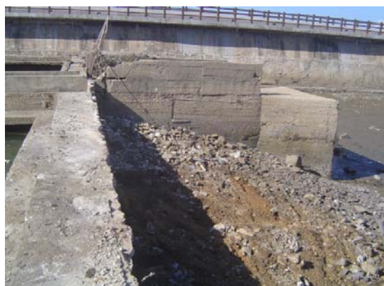
魚池施工完成
