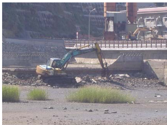
魚池及周邊施工
