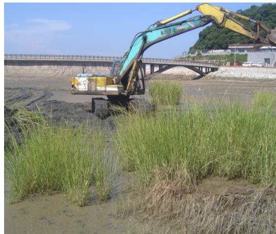
濕地周邊施工
