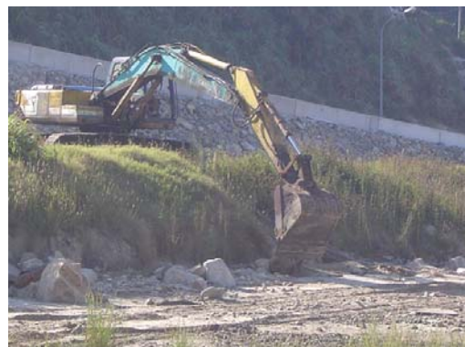
魚池及周邊施工
