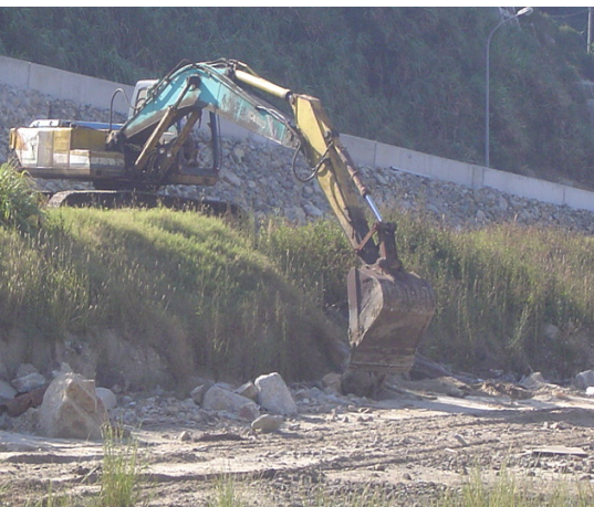
濕地周邊施工
