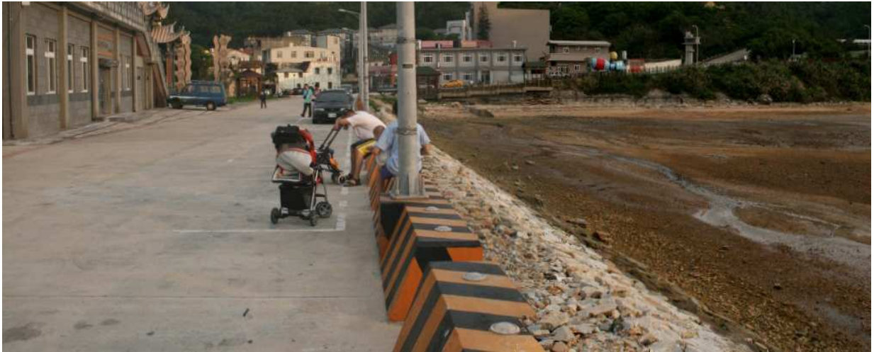
圖 9 邊坡為硬鋪面及礫石
