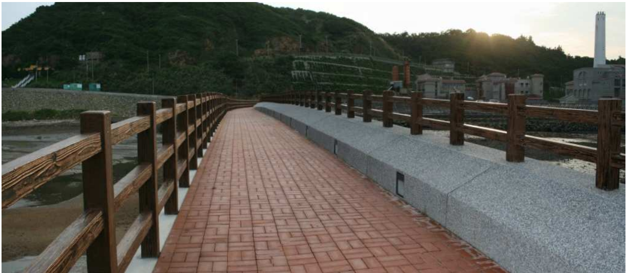
圖 10 現況景觀設施
