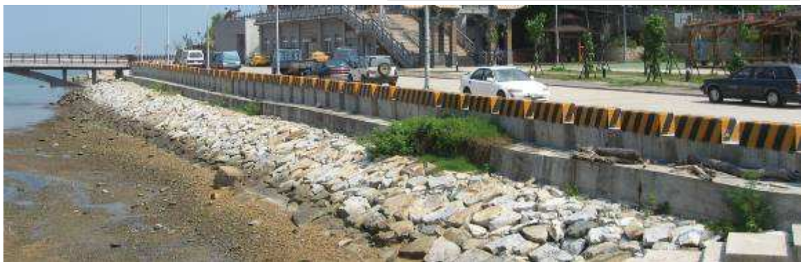
圖 31 右側邊坡現況照片
