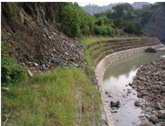
土石籠袋完工照片
