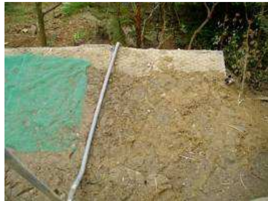
土石籠袋周邊覆土固定
