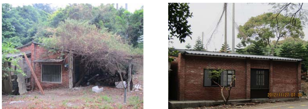
圖 59 遊客服務中心修繕(左-修繕前；右-修繕後)
