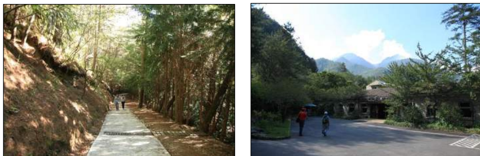
■桃山瀑布步道之沙漿混泥土鋪面（左）與武陵山莊前方車道之柏油鋪面
