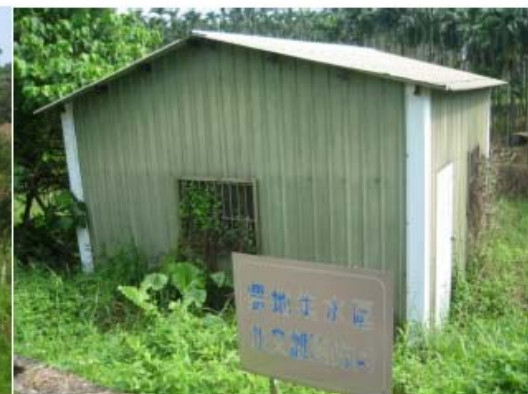
濕地周圍區域-農地集水區水文觀測站
