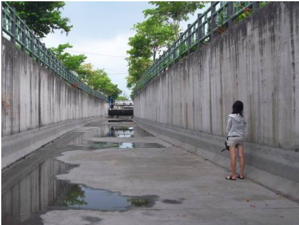
荊仔埤圳 100 年 8 月 10 日現況情形
