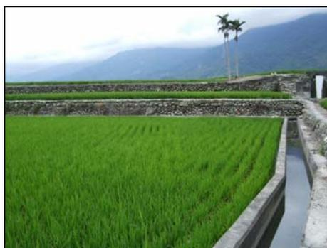
圖 3-5-1、引水渠道與砌石護坡
