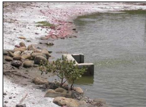
圖 3-4-47、設計緩斜坡，以紅磚護坡
