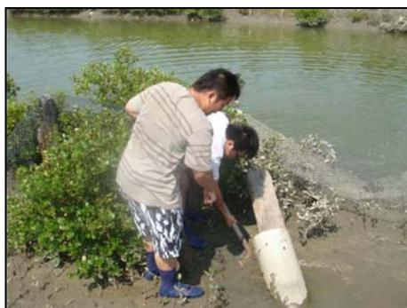
圖 3-4-72、颱風過後，挖通清理阻塞的引水管
