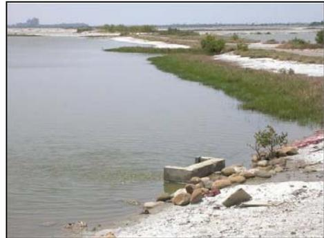
圖 3-4-43、設計緩斜坡，以紅磚固坡，種植海雀稗
