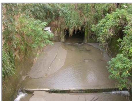
圖 3-4-32、鋼筋水泥之排水箱涵
