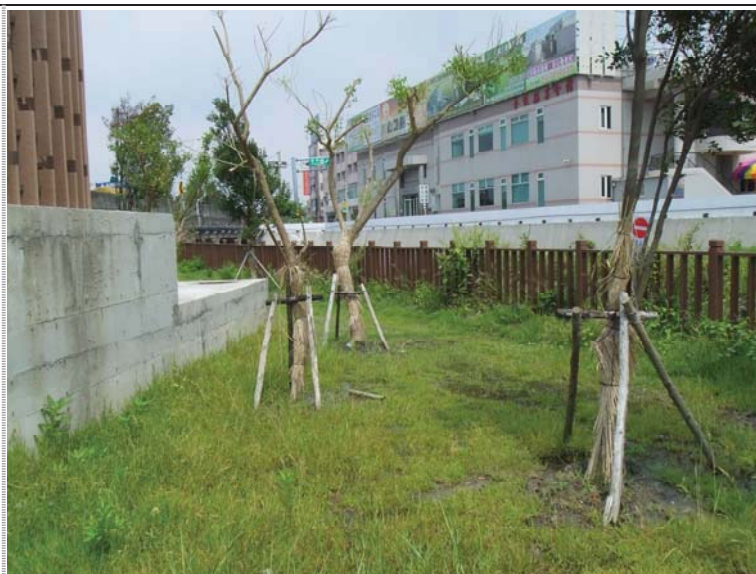
抽水風車施 工 前
