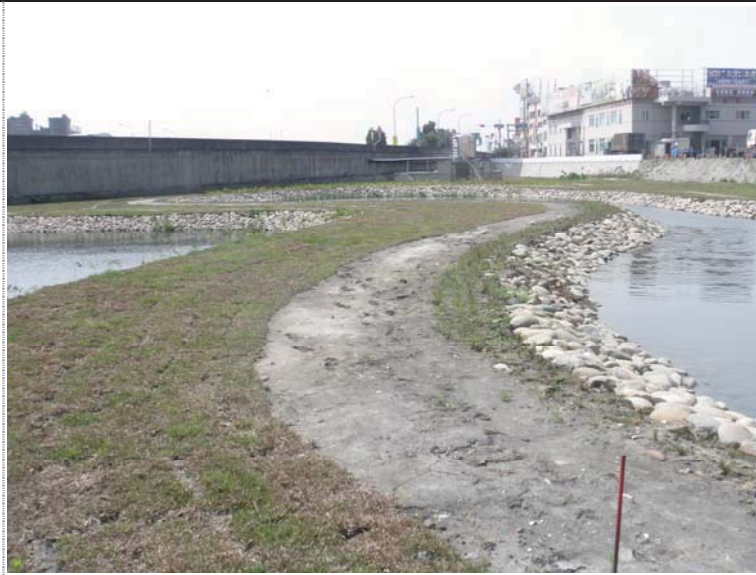
環區踏石步道施工前
