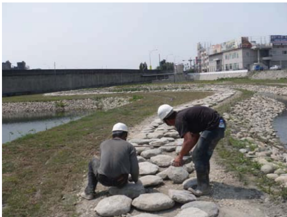
園區步道施作中/執行過程 照片
