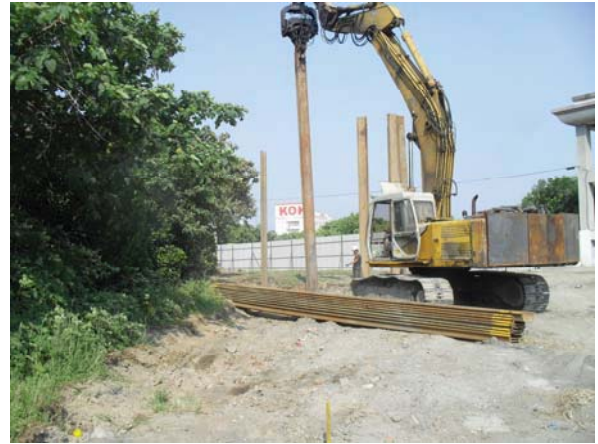
沉降池施作前/執行前照片
