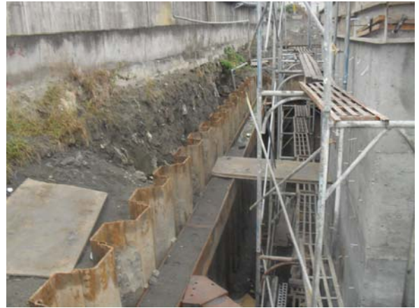
淨水槽施作中/執行過程 照片
