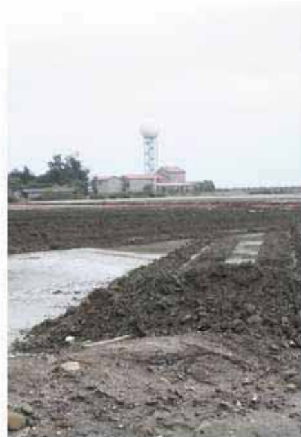
圖4. 20120405台區濕地施作
