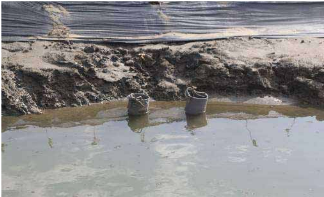
圖 3- 6：濕地營造施作-埋設引流暗管重力引水現場圖
