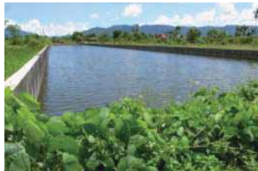
照片 26 因兩旁土地砌水泥牆無法排水而變成魚池
