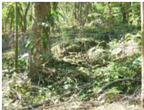
照片 12 濕地上邊坡緩坡處崩積物
