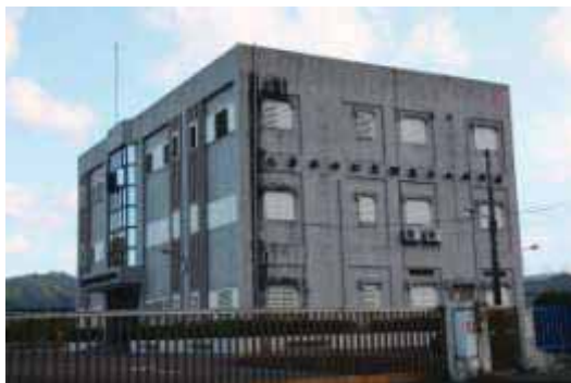
照片 4 光華工業區污水處理廠
