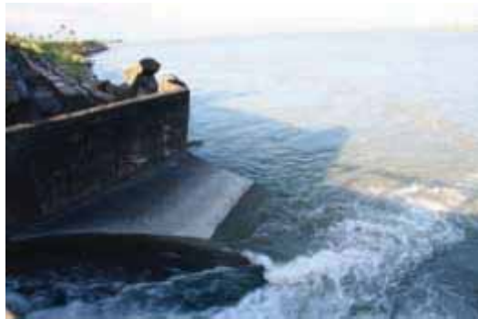
照片 7 大排水溝與花蓮溪匯流處
