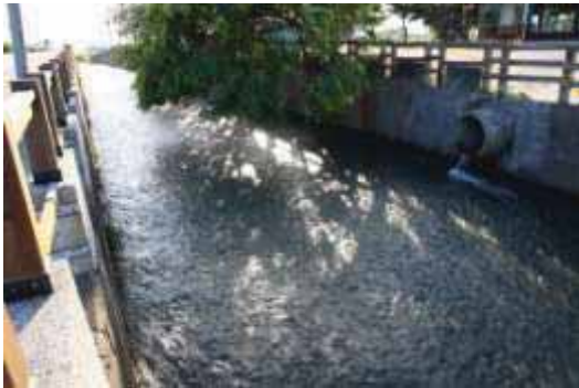
照片 6 華中路大排水溝
