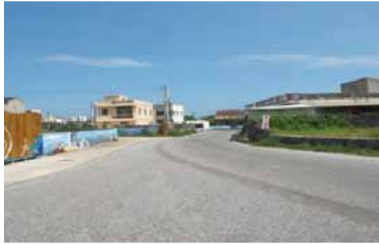
照片 121. 進入青螺村之鄉間道路入口夏季乾淨美麗景觀
