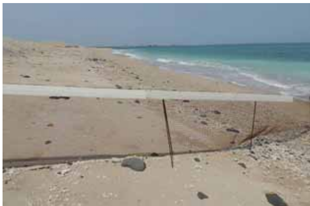
平滑的塑膠板能防止老鼠攀爬.
