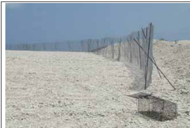
剛架設完成的防蛇網.
