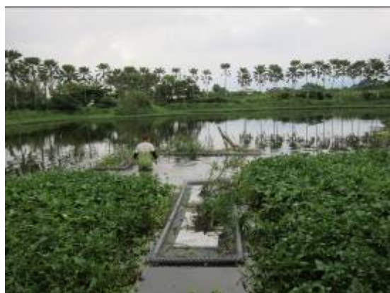
人工浮島入水
